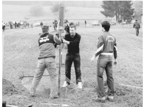
Mit dem Rammeisen werden die Stützpfeiler gesetzt.
