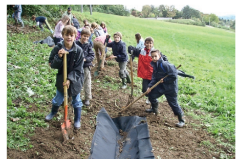
Schulkinder dichten Kleingraben ab
