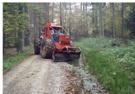
Mulde maschinell ausheben
